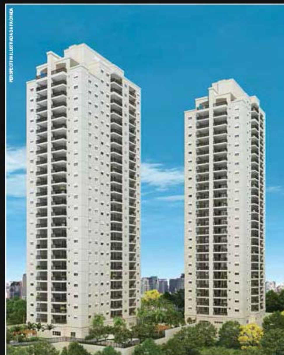
Chácara Cantareira Obras aceleradas • Dentro do prazo
