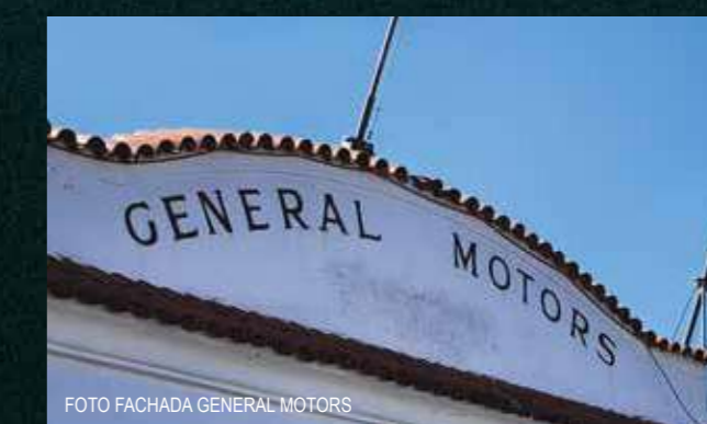
FOTO FACHADA GENERAL MOTORS
